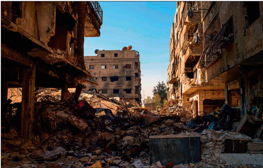
Разрушенный боевиками ИГИЛ Дамаск.
